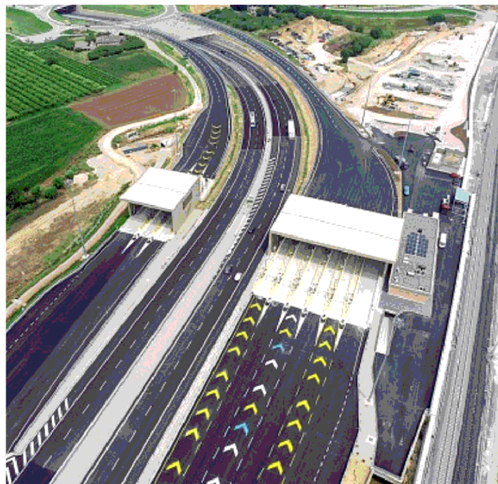
Otto piste Il nuovo casello della autostrada Brescia-Padova a Montecchio inaugurato ieri, fotografato da un drone
