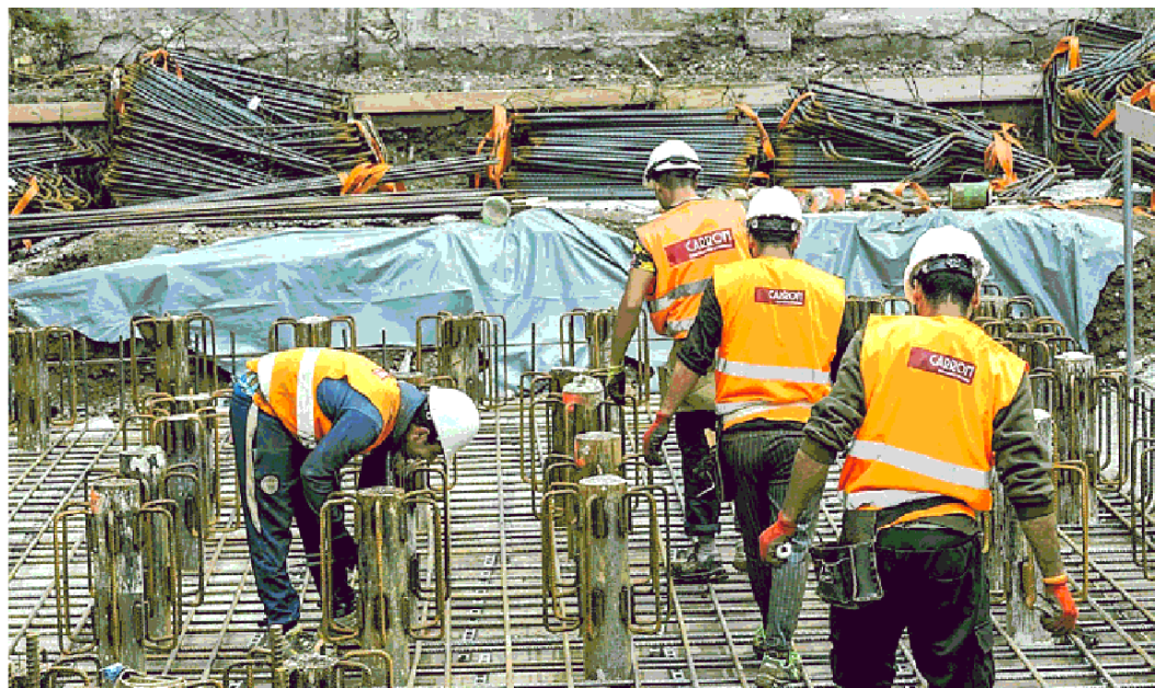
Operai del gruppo Carron al lavoro all'interno di un cantiere
