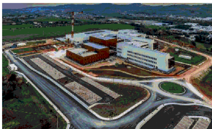
La struttura e i servizi occupano 68 mila metri quadrati di superficie (foto Zeppilli)
